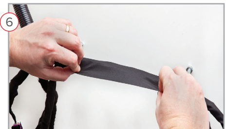
6 Inner sealing strip is secured to the outer sealing strip, hand pressure is applied La línea de adhesivo interior deberá de colocarse sobre la línea de adhesivo exterior y hay que aplicar presión para sellarlo
